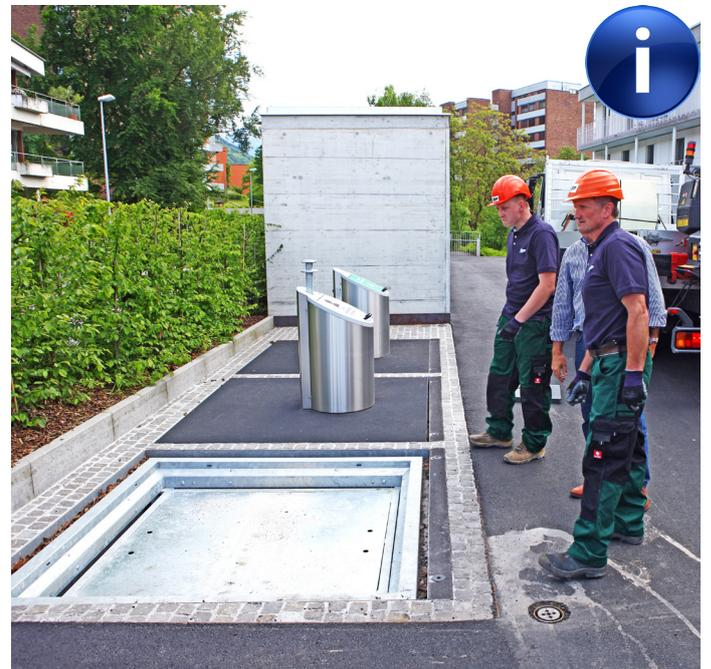
Pour les opérations de nettoyage et de maintenance de la cuve en béton, il est possible de démonter la trappe de visite du plancher du Sécuromat.
