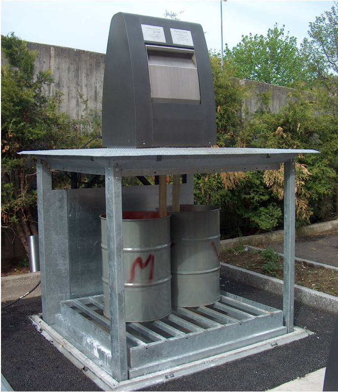
Point de collecte pour huiles usagées avec 2 conteneurs de 159 litres
